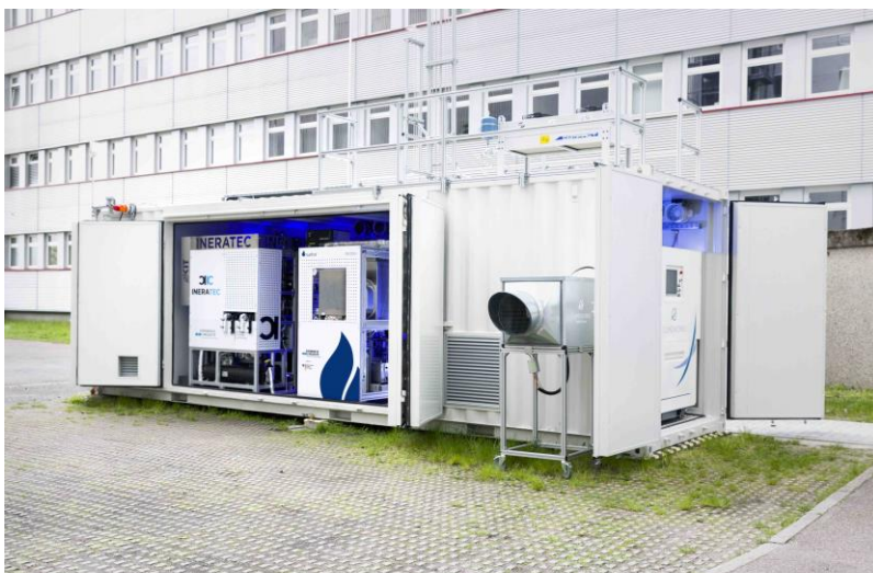
Weltweit erste integrierte Power-to-Liquid (PtL) Versuchsanlage zur Synthese von Kraftstoffen aus dem Kohlendioxid der Luft. (Foto: Projekt P2X)
